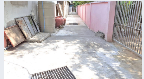
« โครงการปรับปรุงถนน ขอยบังคม หมู่ที่ 1 »
