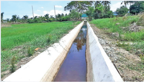
« โครงการดาดคอนกรีตคลองไส้ไก่ หมู่ที่ 2 »
